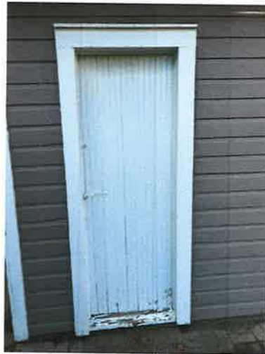
Garage Door Replace w/ Steel door
